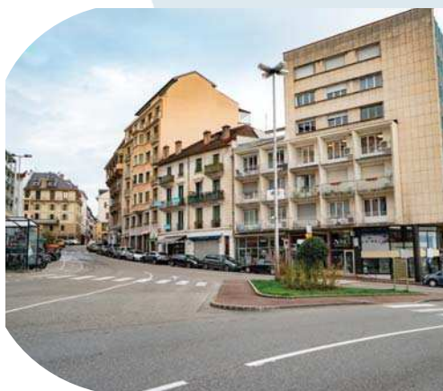
Les aménagements se poursuivent dans le centre-ville pour mieux sécuriser les cheminements piétons et vélos. Prochainement la place de la Libération.
