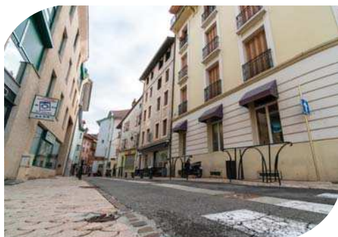
Les travaux concernent le réaménagement de la rue de la Monnaie et du jardin au cœur de la Gaffe.
