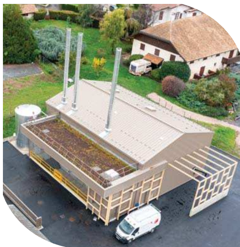
En prévision de l'extension du réseau, la chaufferie va être légèrement agrandie.
