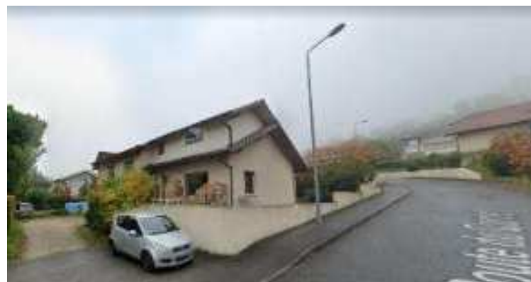
33 Route du Cornet Maison individuelle RDC+1
