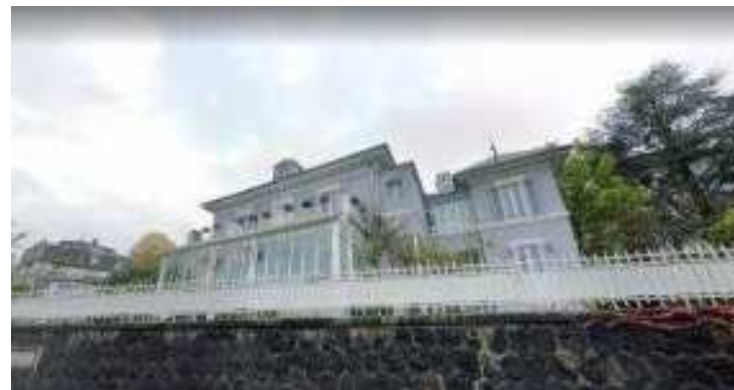
19 Avenue de La Gare Villa RDC+1
