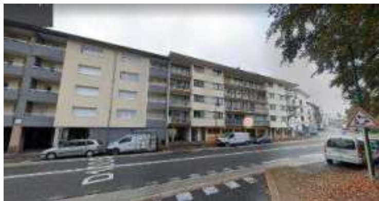
Avenue Anna de Noailles Logements collectifs RDC+4
