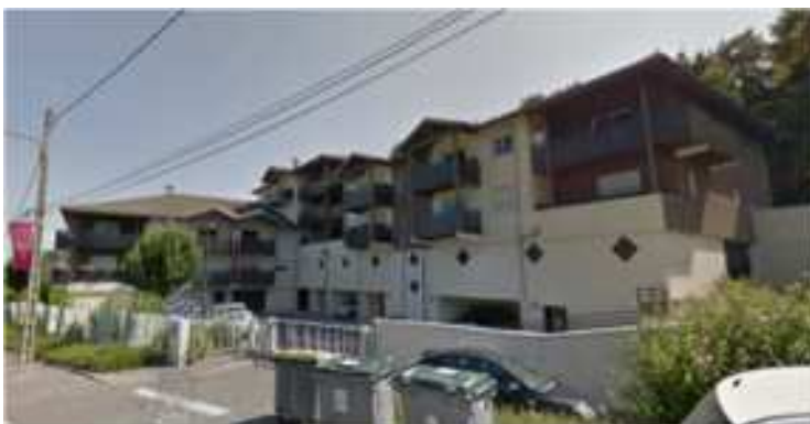
3 route de Bissinges Logements collectif RDC+2
