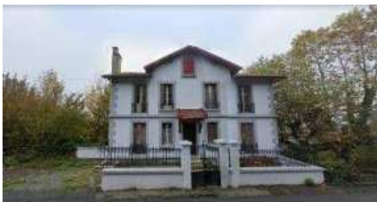
40 Route de la Corniche Maison individuelle RDC+1
