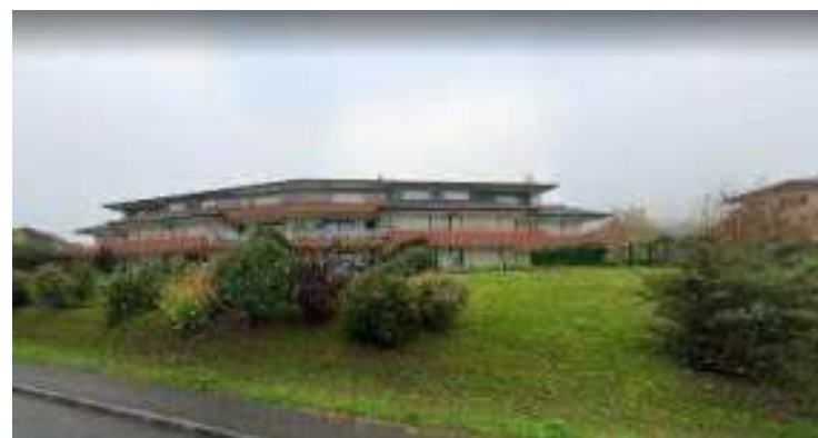
20 Boulevard du Clou Logements collectifs RDC+2
