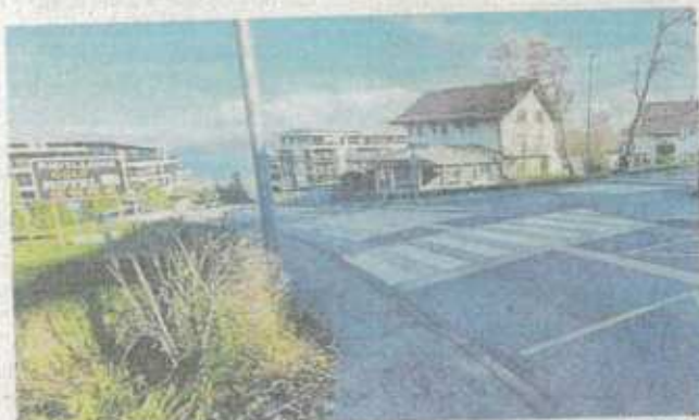
L'avenue de Larringes à fort trafic qui, aujourd'hui, scinde le quartier en deux pourrait voir les flux de transit être reportés sur les routes de Bissinges et du Golf. Photo Le DL/FG.
