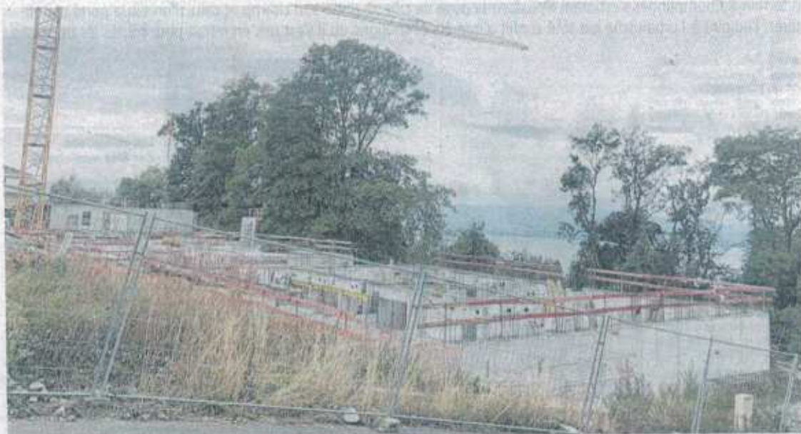
La construction des trois premiers immeubles du vaste programme immobilier des Tours a commencé.
