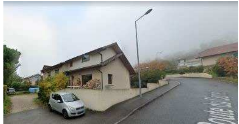
33 Route du Cornet Maison individuelle RDC+1
