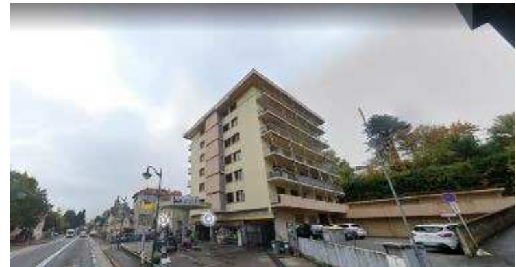
9 Avenue Anna de Noailles Logements collectifs RDC commerces + 6
