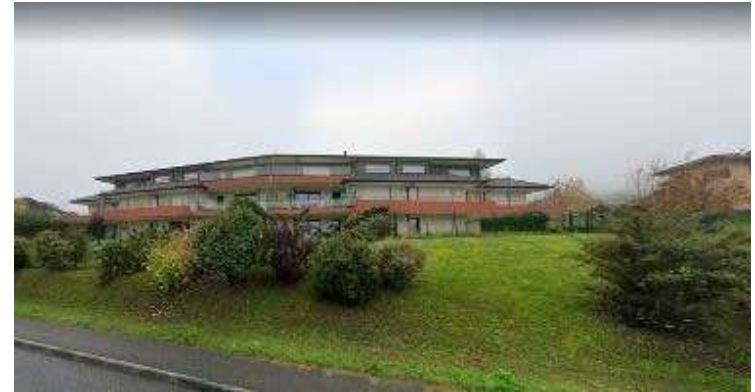
20 Boulevard du Clou Logements collectifs RDC+2
