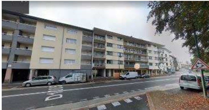
Avenue Anna de Noailles Logements collectifs RDC+4
