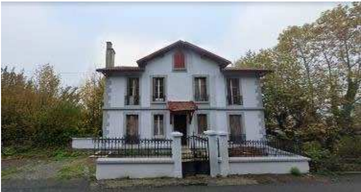
40 Route de la Corniche Maison individuelle RDC+1
