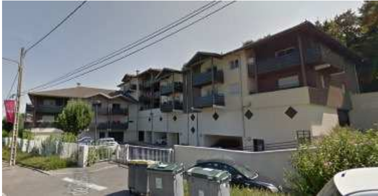
3 route de Bissinges Logements collectif RDC+2
