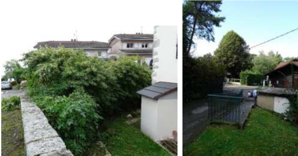
Nant d'Enfer entièrement canalisé/enfoui à la limite de Neuvécelle (à droite)
