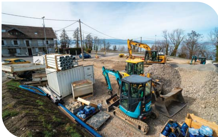
La communauté de communes travaille actuellement pour déplacer et renforcer les réseaux d'eaux potable et d'assainissement.
