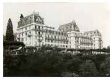
Hôtel Splendide, façade principale, photographie vers 1910. A.M. Evian, dépôt S.A.E.M.E.
